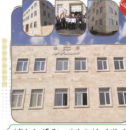
افتتاح ساختمان معاونت خدمات شهری منطقه ۴ شهرداری اسلامشهر مجموع بنا ۱۴۰۰ مترمربع که شامل ایستگاه آتش نشانی، اوزنرانی می باشد
