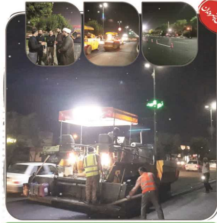
پروژه عملیات عمرانی بزرگراه آیت الله سعیدی حدفاصل بلوار رودخانه کن تا میدان نماز شامل ۵۰,۰۰۰ مترمربع تراش و روکش مکانیزه آسفالت
